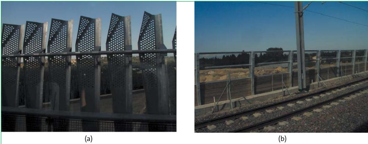
**Figure 6 :** Images d'un pare-vent poreux (a) et d'un mur plein (b)
