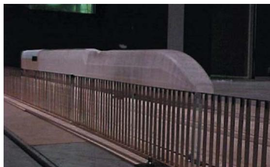
Écran poreux à lames, hauteur 3 mètres au-dessus du plan de roulement
